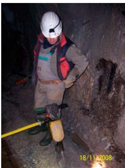
Dela v podkopu Topla potekajo v majhnem jamskem profilu z uporabo odkopnih kladiv.
