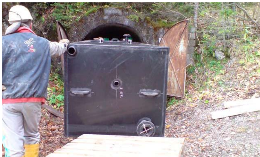
Vodni zbiralniki pred transportom v podkopo Topla; šli so po milimetrih mimo bokov jamske podgradnje.
